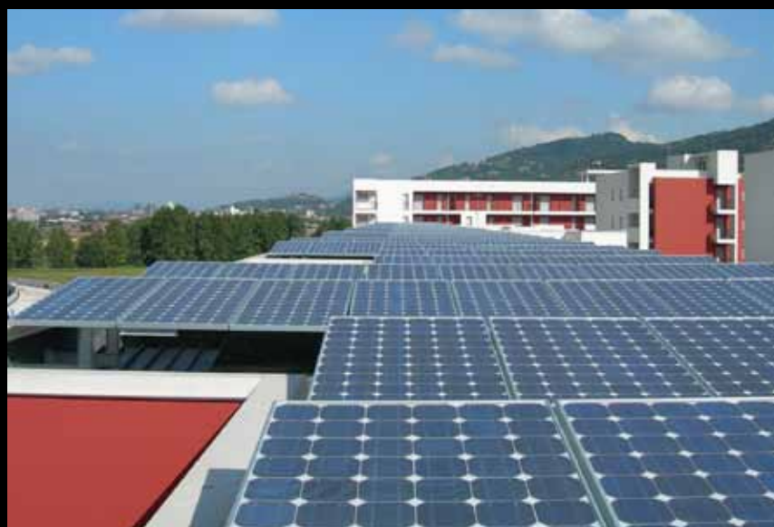
Impianto fotovoltaico da 55KWp non integrato allacciato a settembre 2009
