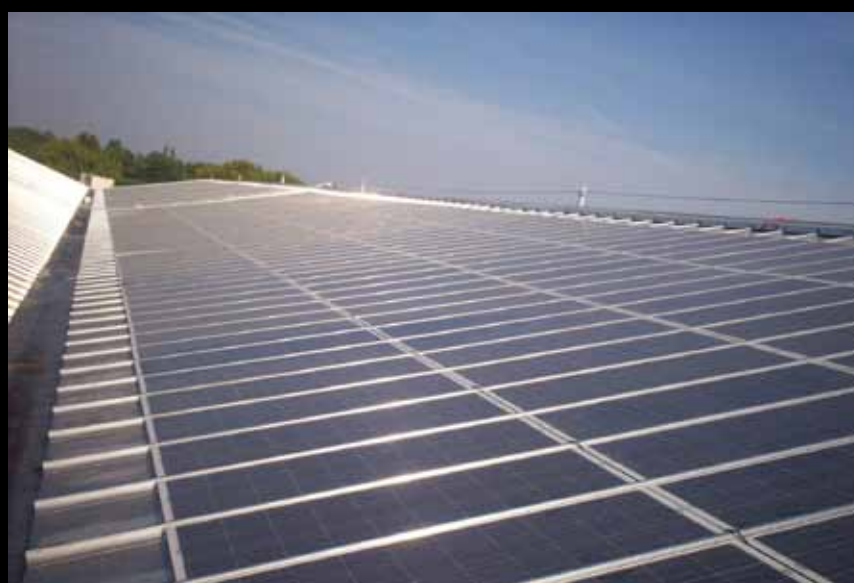
Impianto fotovoltaico da 300KWp totalmente integrato allacciato a dicembre 2009
