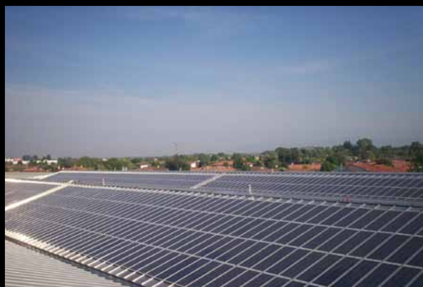
Impianto fotovoltaico da 300KWp totalmente integrato allacciato a dicembre 2009
